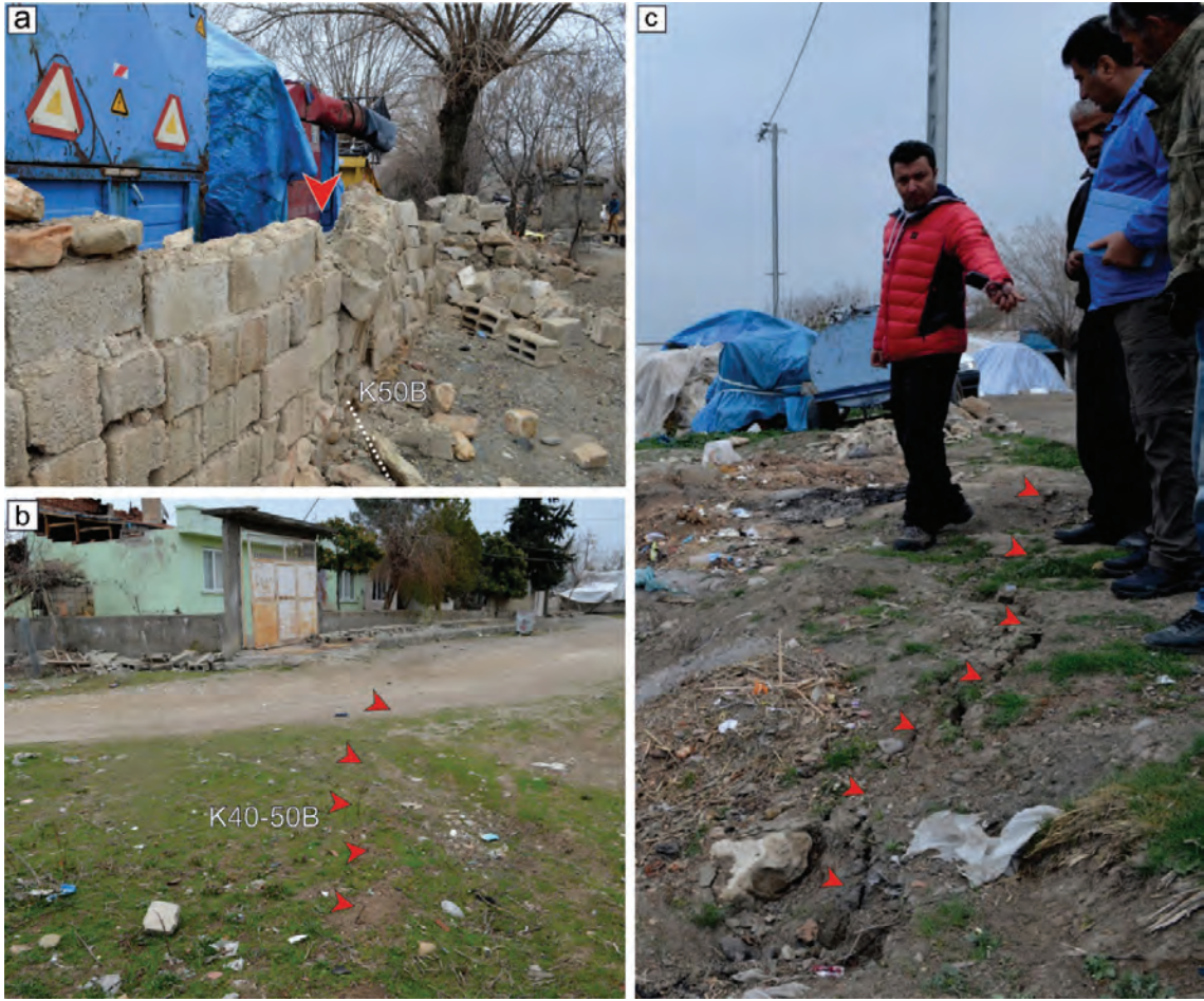
Şekil 5. 2 Mart 2017 depremi sonrası (a) Akdamar köyünde gözlenen sağ yanal doğrultu atımlı faylanmayı işaret eden çizgisellik, (b) Samsat ilçe merkezi ve (c) Taşkuyu köyünde gözlenen yüzey çatlakları.
